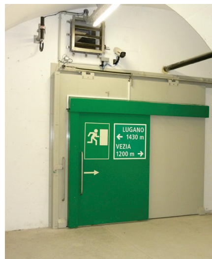
Drehflügeltüre EI30 für Rettungsfahrzeuge; Schiebetüre EI30 für Fluchtweg Personen
