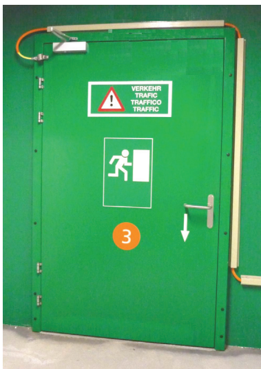
Drehflügeltüre EI30 bis EI90 Schiebetüre EI30 mit automatischer Schliessung
