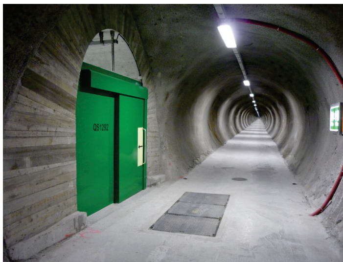
Drehflügeltüre EI30 bis EI90 Schiebetüre EI30 mit automatischer Schliessung
