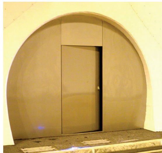
Abschluss Entwässerungsnische
