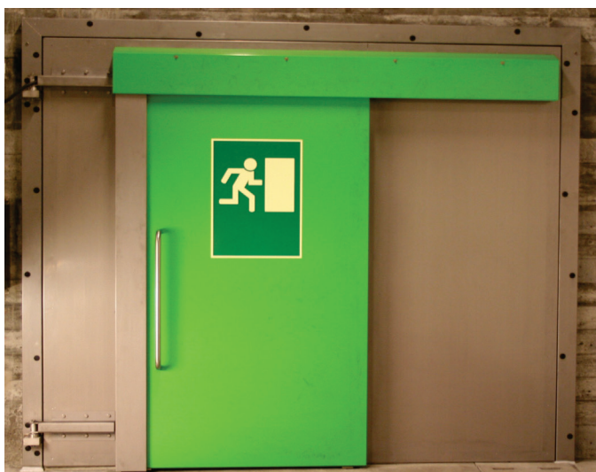
Drehflügeltüre EI30 für Rettungsfahrzeuge; Schiebetüre EI30 für Fluchtweg Personen
