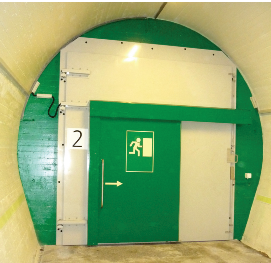
Drehflügeltor mit Fluchtschiebetüre EI30
